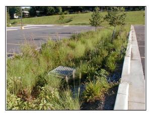
Figure 5-6. Biofiltration Planter
